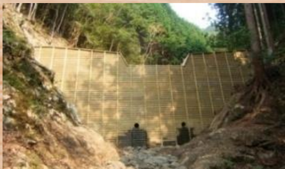
木製型枠を使用した谷止工
