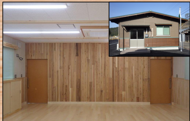
壁面にCLTを使用 (安芸森林管理署 野友・北川、安倉合同森林事務所)
