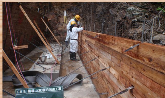
谷止工の木製枠組立状況
