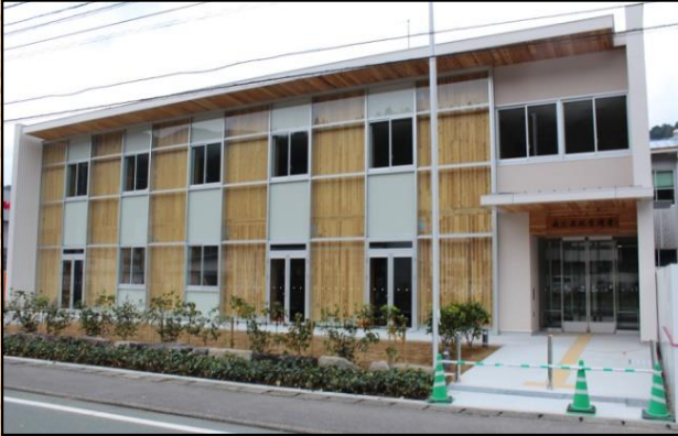
国の庁舎整備で初めて本格的にCLTパネル工法を採用した嶺北森林管理署庁舎
