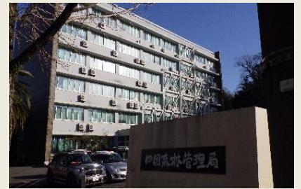
現・四国森林管理局庁舎
