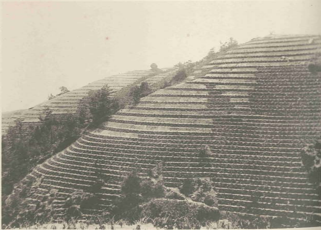
前葉、積苗工事完成せる状況にて、植栽樹種は黒松と山桜とを混植せり
