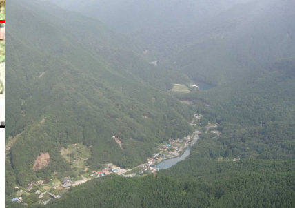
⑤徳島県三好市(名頃ダム)
