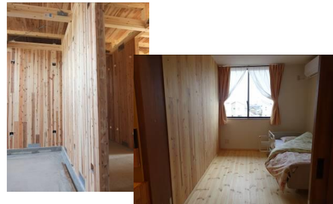
高齢者施設 2階壁 (高松市)
