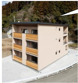
CLT建築物国内 第1号(高知県)
