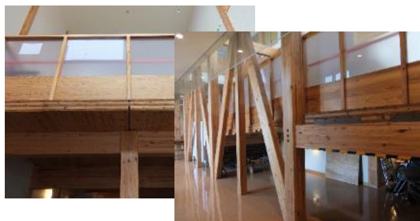
高齢者施設 屋内スロープ (観音寺市)
