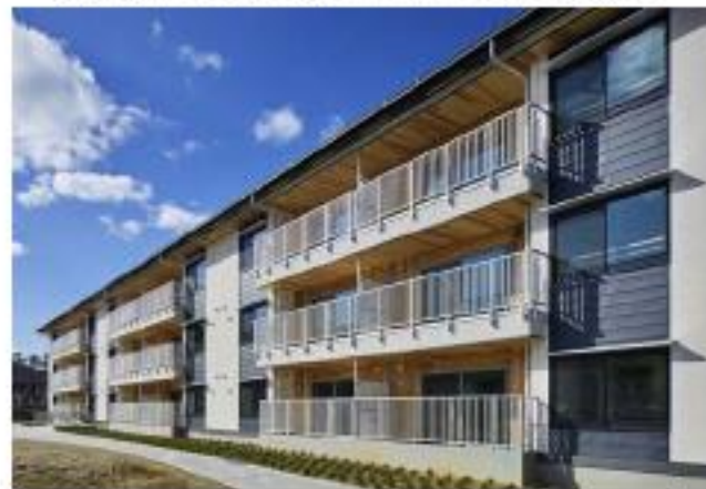
共同住宅：復興公営住宅（福島県）
