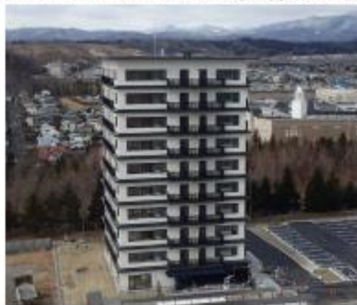
共同住宅：PARK WOOD 高森（宮城県）
