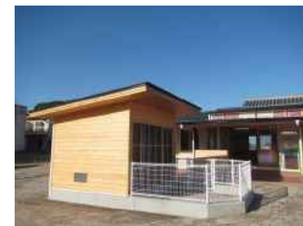
幼稚園 屋根 (観音寺市)
