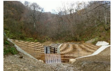
【治山ダム（酒田市）】
