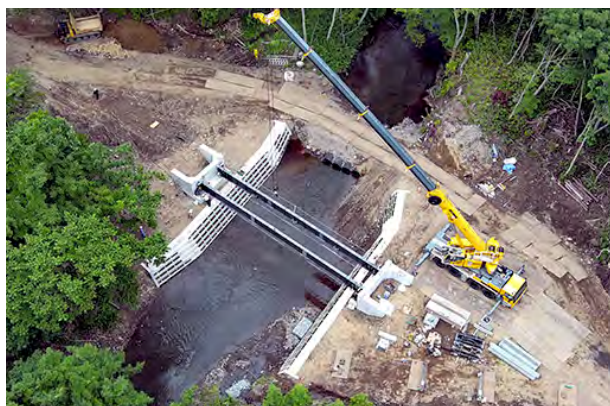
全長22.2mの橋の工事の様子
