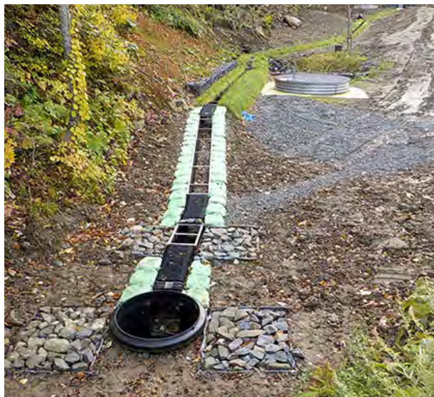
地すべり区域に設置した集水井・水路工
