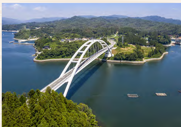
気仙沼大島に架かる「大島大橋」
