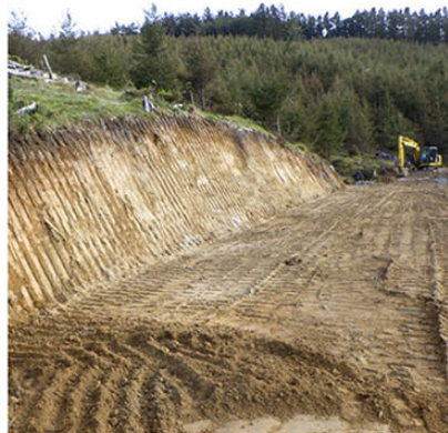
ICT技術を活用して掘削を行った法面
