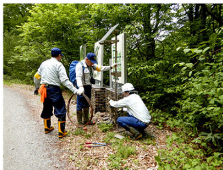
入山カウンターの設置
