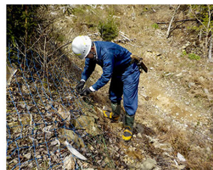
防鹿柵の補修を行っている筆者
