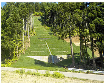
復旧治山工事完了
