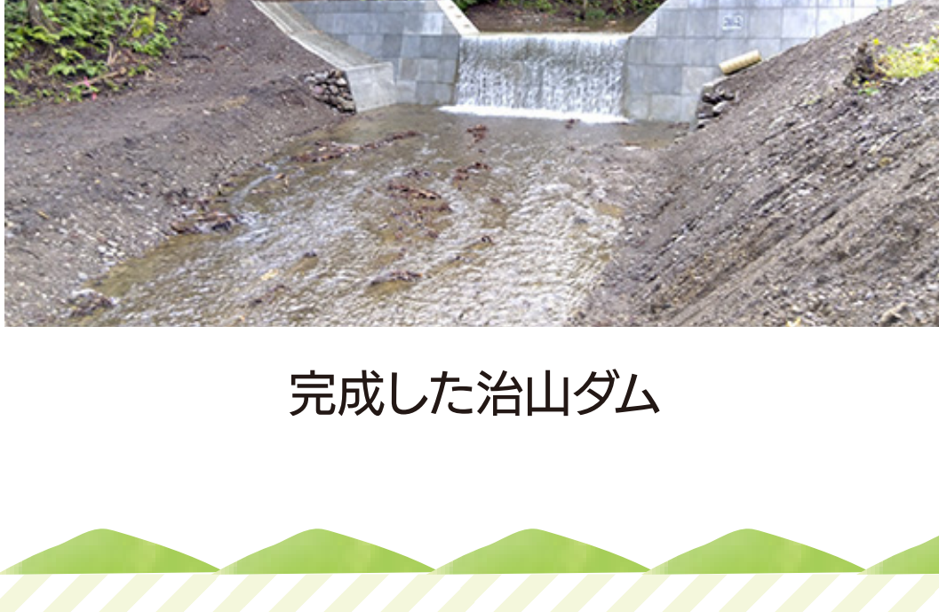
完成した治山ダム
