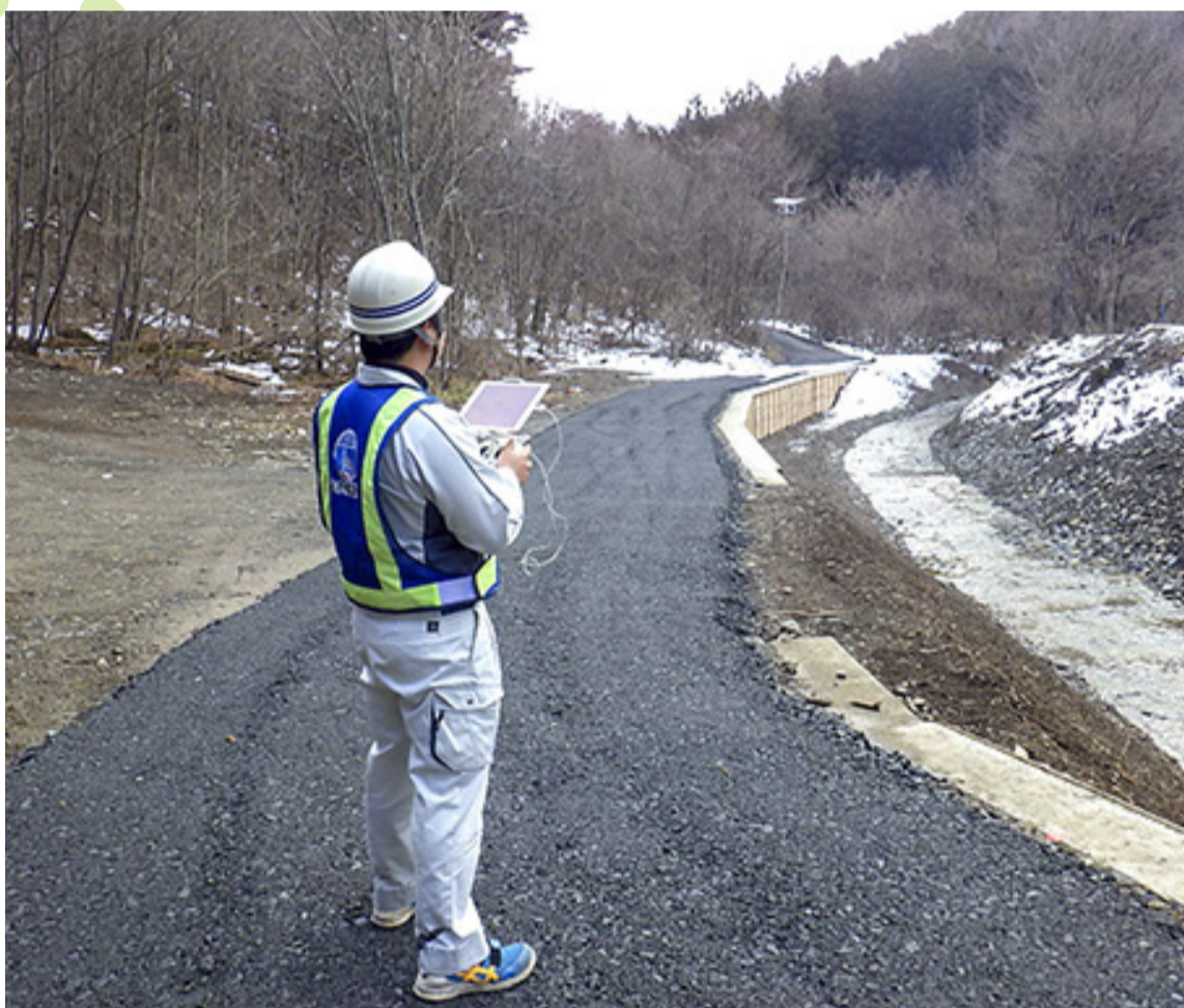
ドローンでの工事写真撮影
