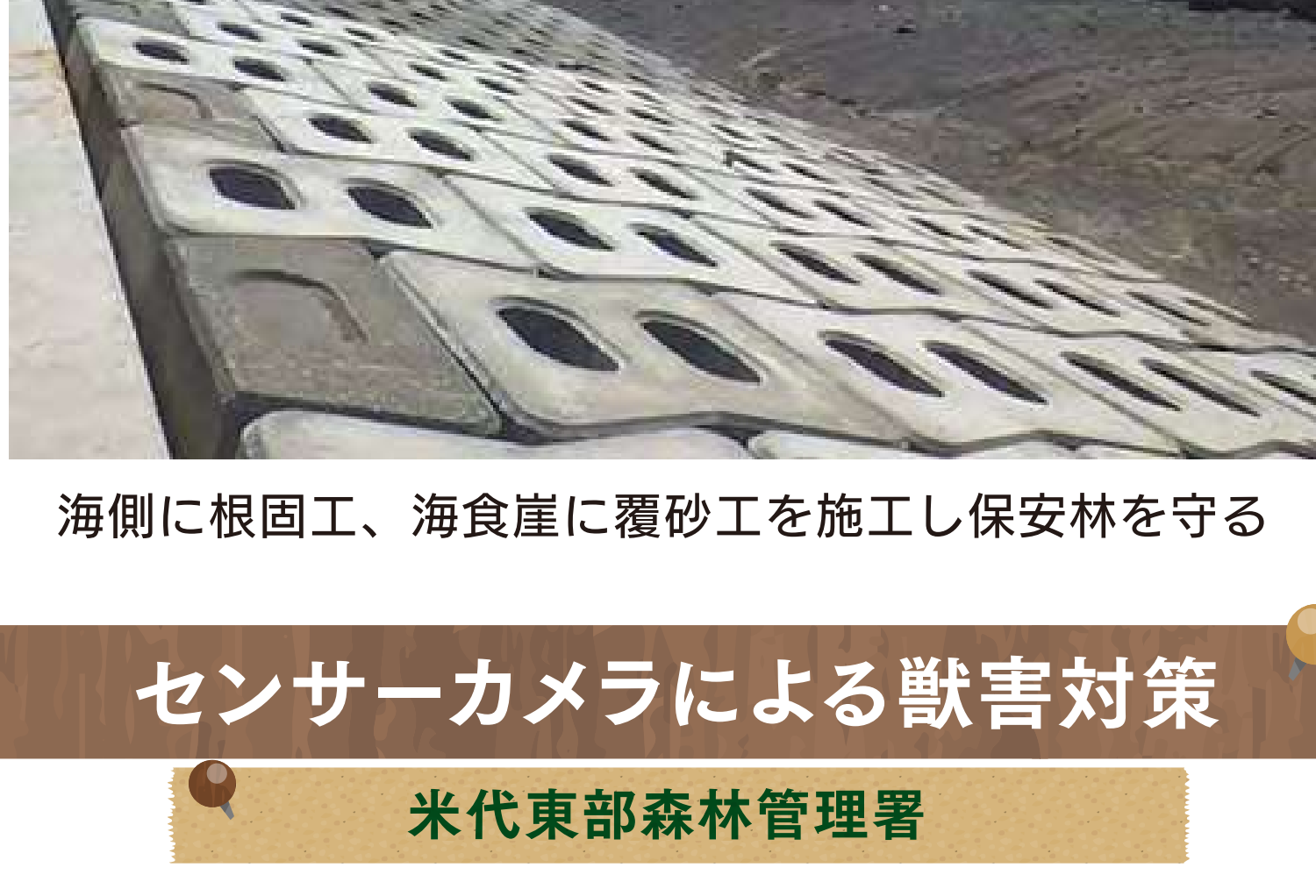
海側に根固工、海食崖に覆砂工を施工し保安林を守る
