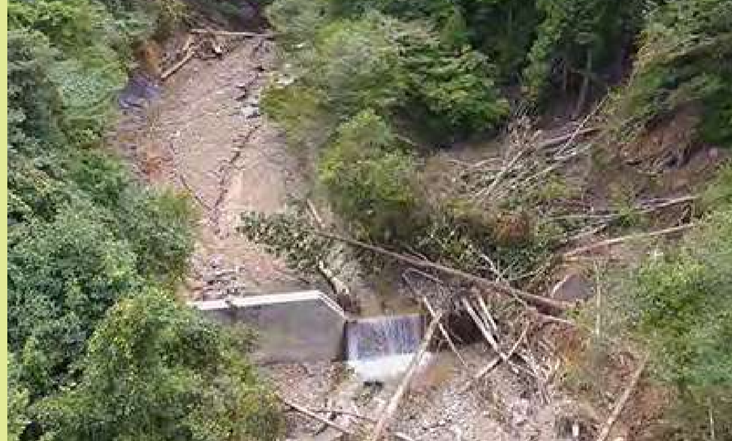
青森県風間浦村の治山施設による土砂や流木の流出抑制
