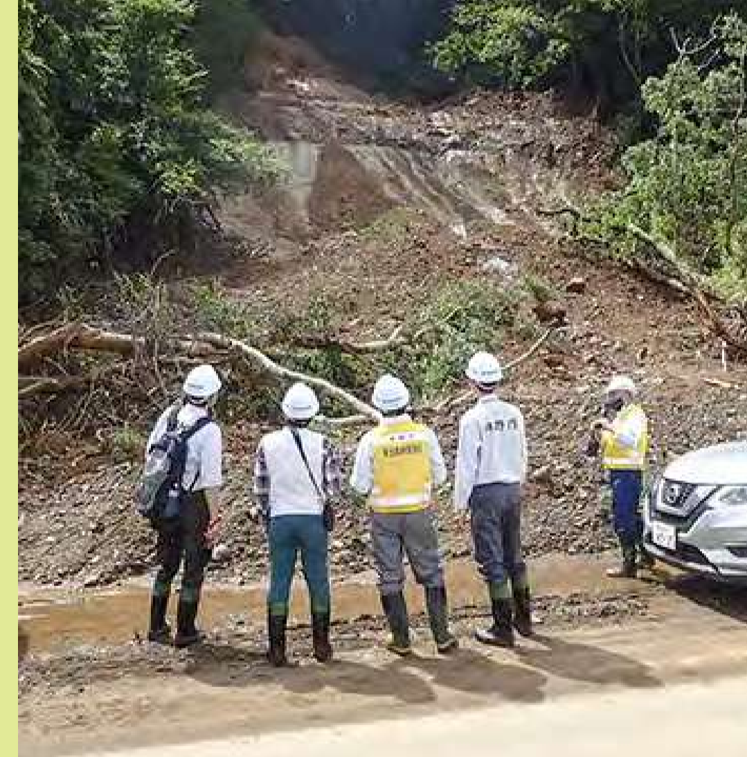
治山技術者の被害状況調査
