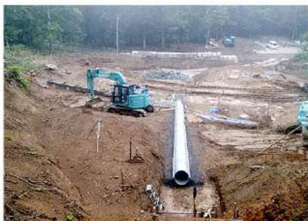
排水施設工事を施工
