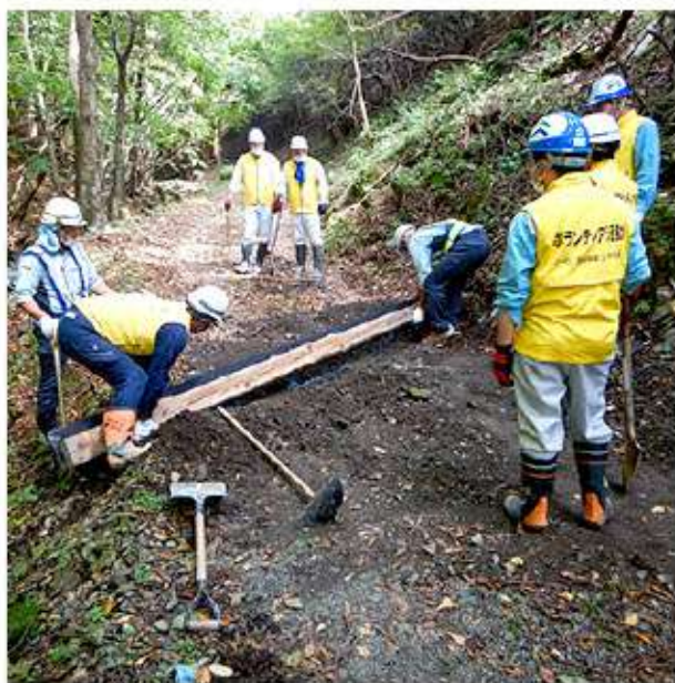
木製路面排水工の施工
