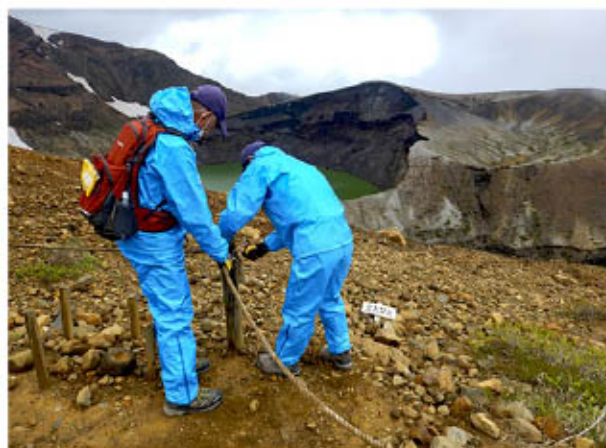
外れたロープの簡易補修作業
