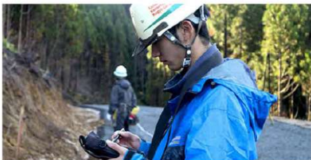
測量作業の様子
