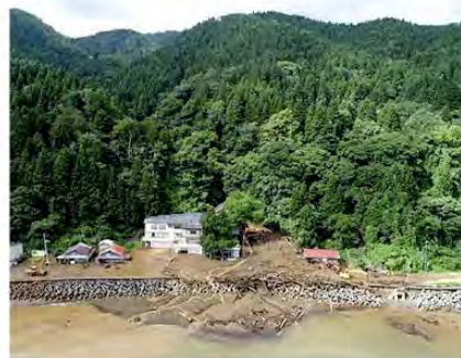
元宇田地区（国道への土砂等流出状況）
