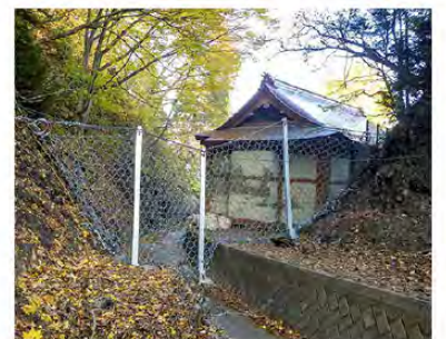
ワイヤーネット設置後（上流側から）
