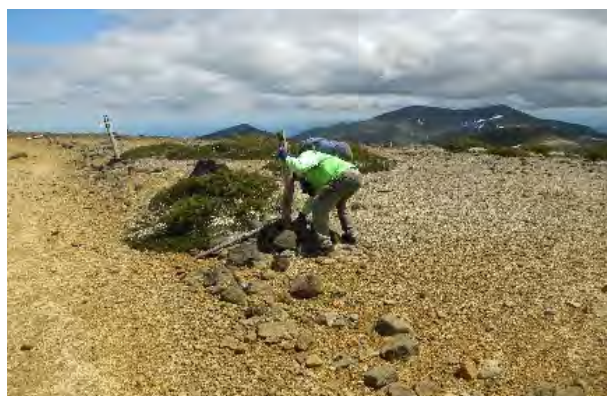
風で倒れた標柱の建て直し
