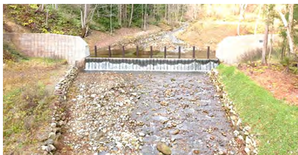
完成したスリットダム工 (秋田県北秋田市森吉字小繋沢国有林)
