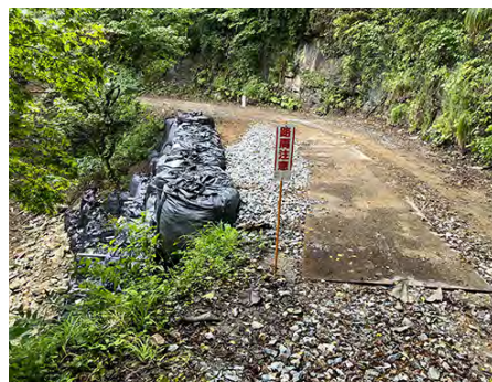
応急復旧後の揚吉林道
