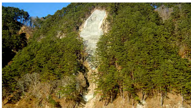
急峻な崖地形での工事完成後の状況
