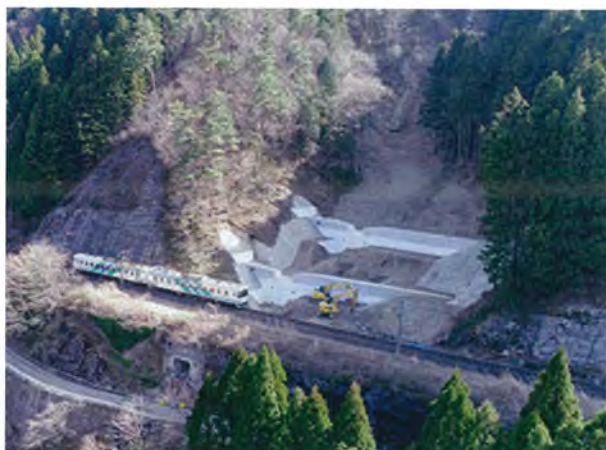
阿武隈急行と治山ダム工事現場
