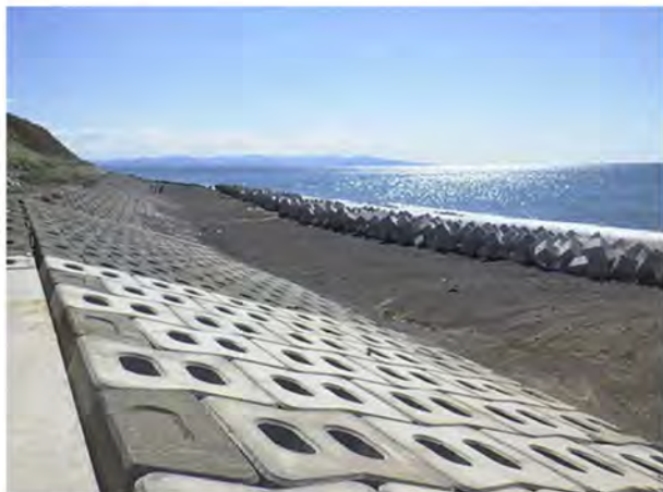
海側に根固工、海食崖に覆砂工を施工し保安林を守る
